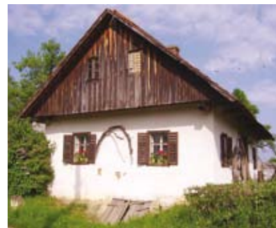
Cimprana hiša v Brengovi
