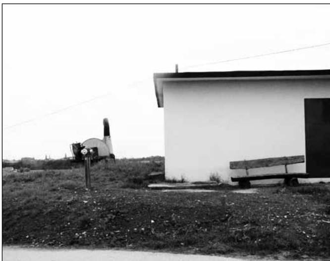
Slika: Izvedeni vodovod
