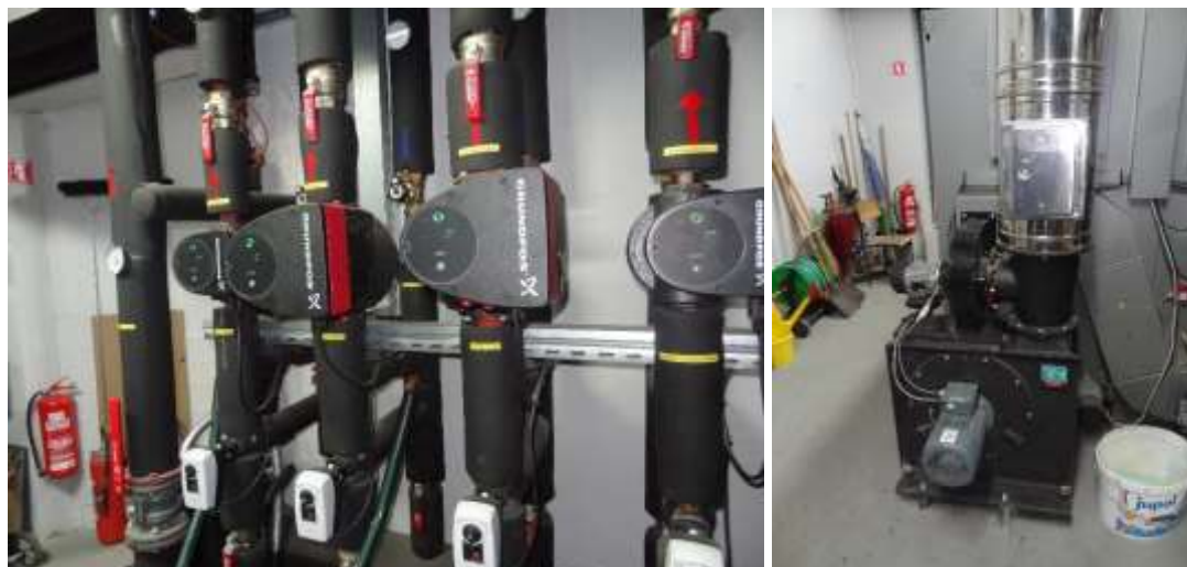
Slika 2: Posnetek del razdelilnika in kotla na biomaso
