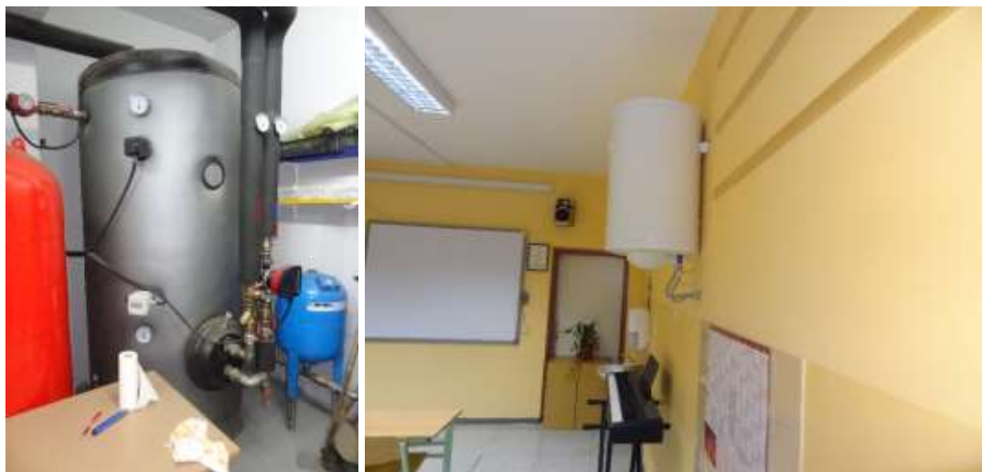
Slika 3: Bojlerji za TSV
