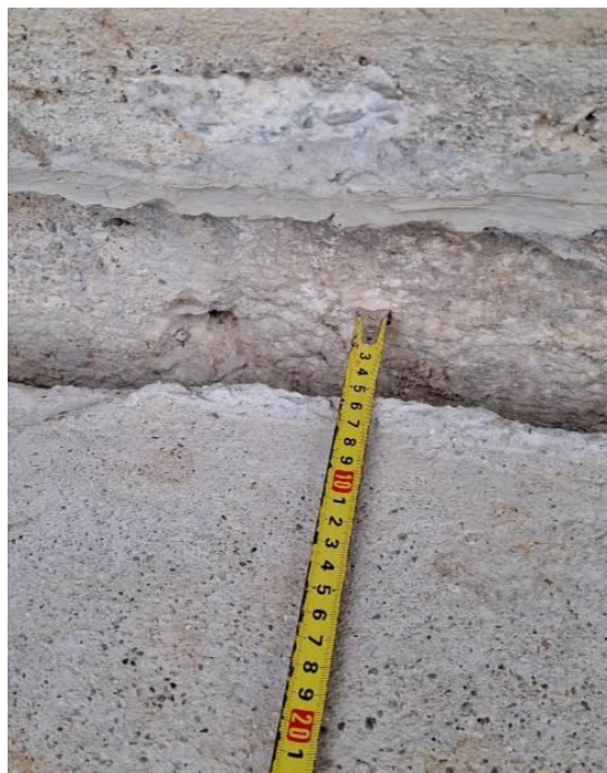
Slika 7 in 8: Odprta razpoka od objektu, južna stran. Širina razpoke do 6 cm.
