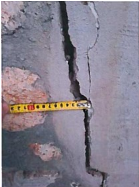
Slika 3: razpoke na Z delu, 3cm
