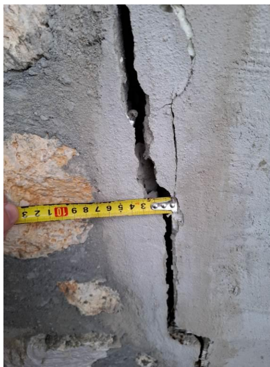
Slika 9 in 10: Odprta razpoka na zahodnem delu severne stene objekta. Širina razpoke do 3 cm.
