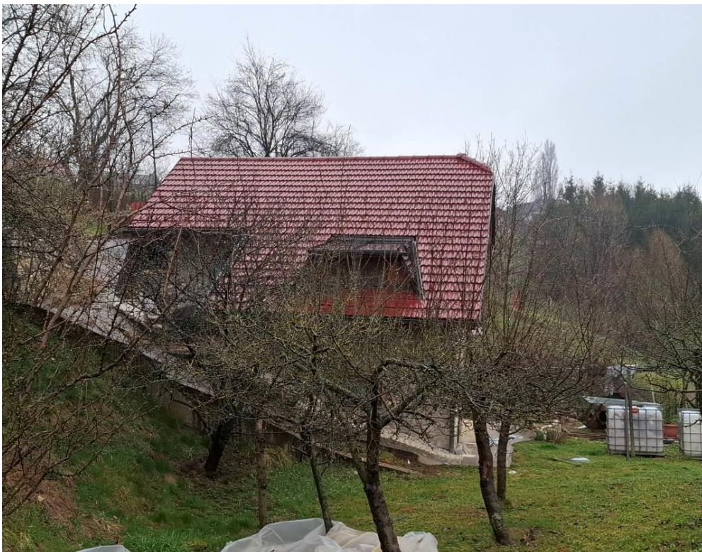
Slika 13: Vidno nagnjen objekt, visi v smeri plazenja terena. Objekta se ne da sanirati.
