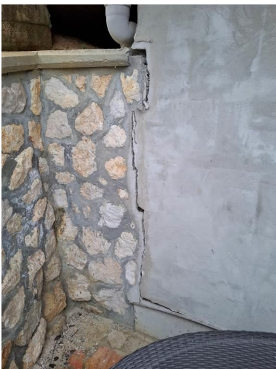
Slika 9 in 10: Odprta razpoka na zahodnem delu severne stene objekta. Širina razpoke do 3 cm.
