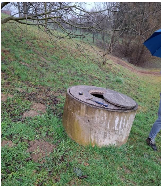
Slika 16: Nagnjen jašek drenaže na parceli, vzhodno od obravnavanega objekta. Globina 2,5 m, veliko vode.
