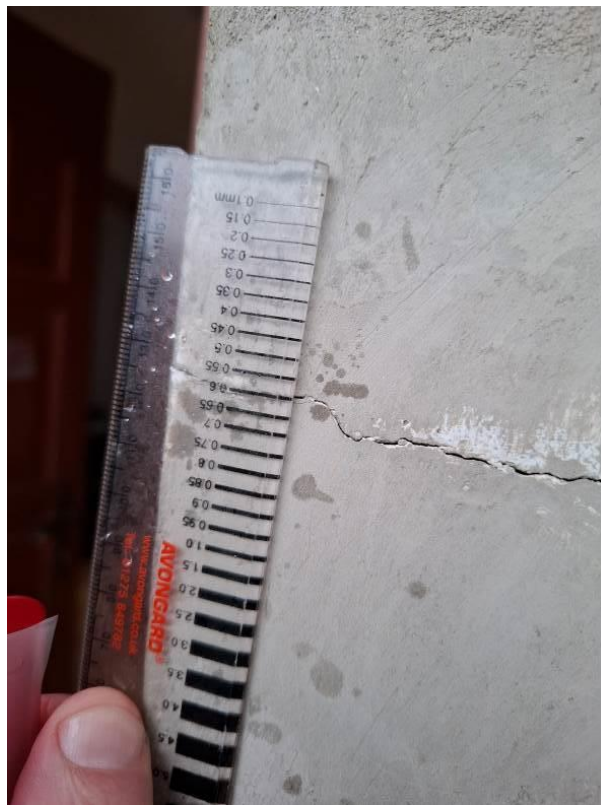
Slika 11 in 12: Razpoke na stopnicah in na steni objekta pri vhodnih vratih v stanovanjski del objekta.
