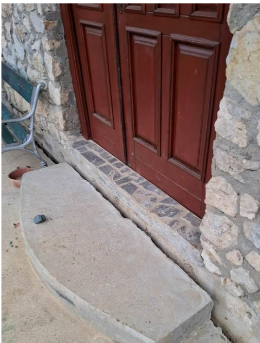
Slika 7 in 8: Odprta razpoka od objektu, južna stran. Širina razpoke do 6 cm.
