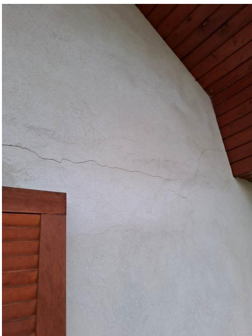
Slika 14 in 15: Razpoke na sprednji strani objekta in razpoke na dovozni cesti – jasno plazenje sicer precej položnega pobočja južno od objekta.
