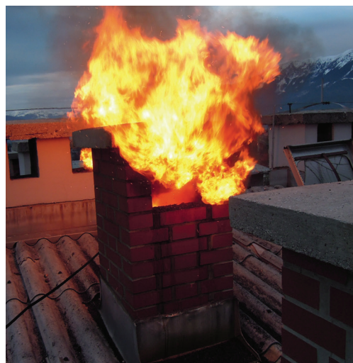
Slika 2: Dimniški požar v razviti fazi – pomembnost lokacije ustja dimovodne naprave
