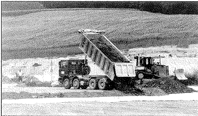
Izvajanje nasutja platoja na obrtni coni
